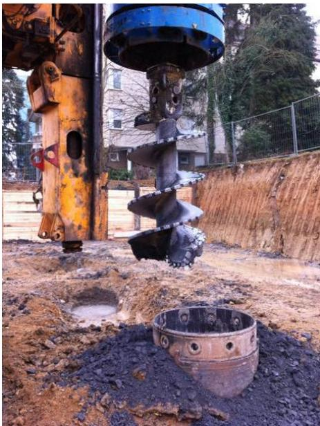
Abb. 14: Schneckenortbetonpfähle
