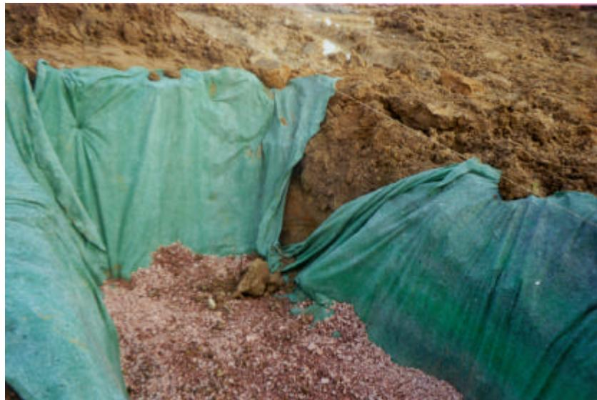
Abb. 17: Anlage einer Rigole mit Filtervlies und Schotterlage
