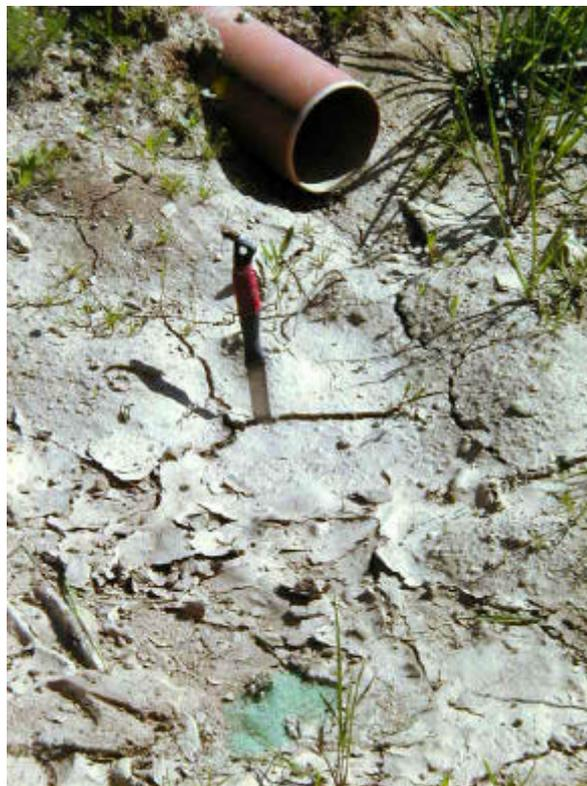
Abb. 26: Zugeschlammtes Filtervlies auf dem Muldenboden (Foto Juni 2001)
