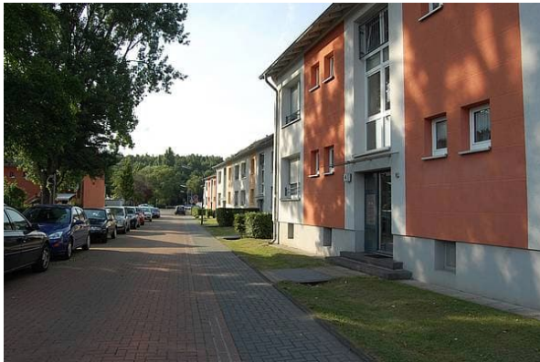
Abbildung 4: Beispiel für offene Gräben (unbefestigt)
