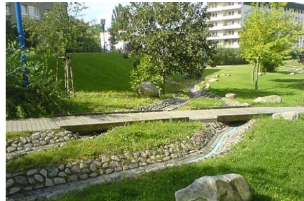
Abbildung 5: Beispiel für offene Gräben (befestigt)
