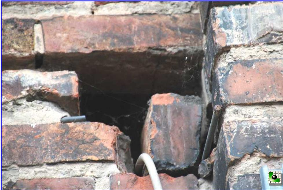
15 **Abb. 17: Fassadenausbruch im Bereich des zu erhaltenen Gebäudetraktes im Südosten des Areals**
